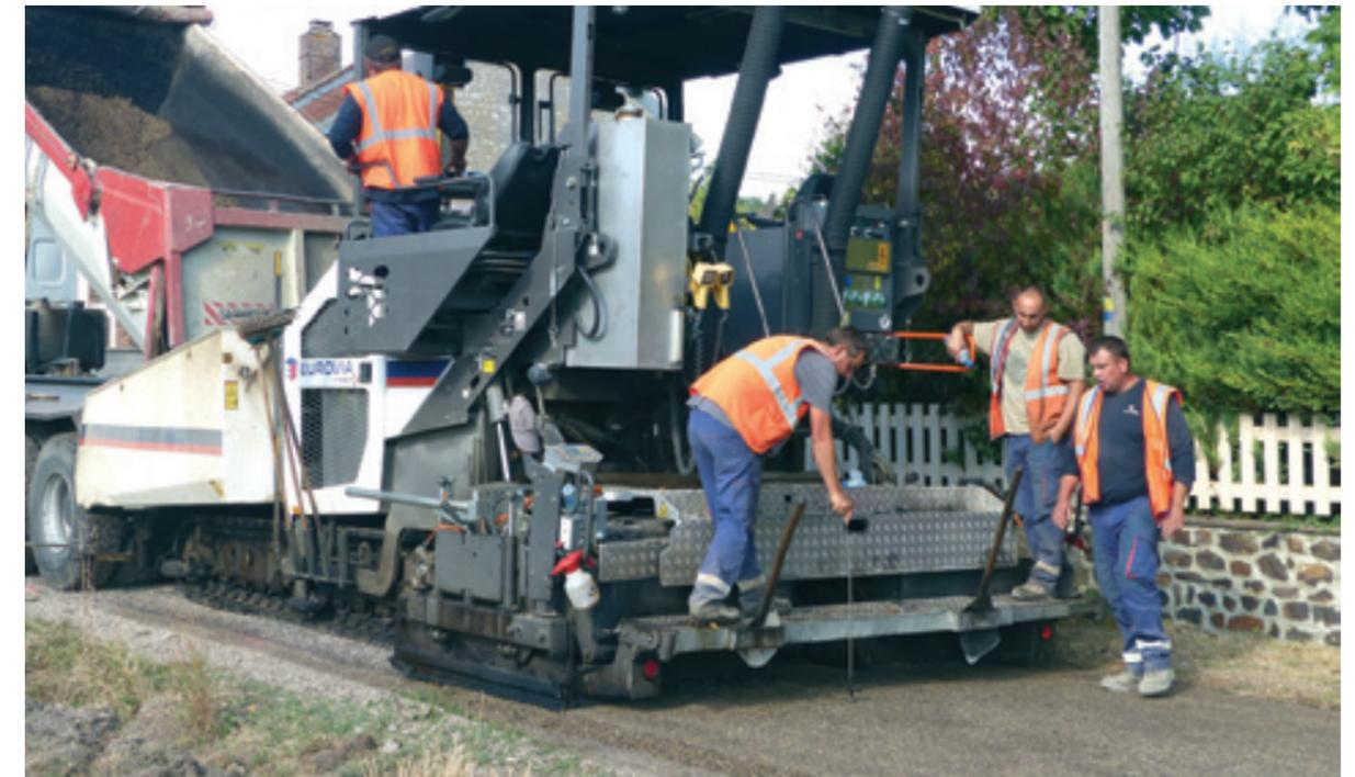
Reprofilage mécanique au finisseur avec de la grave émulsion dans la rue des Gains aux Huchons
