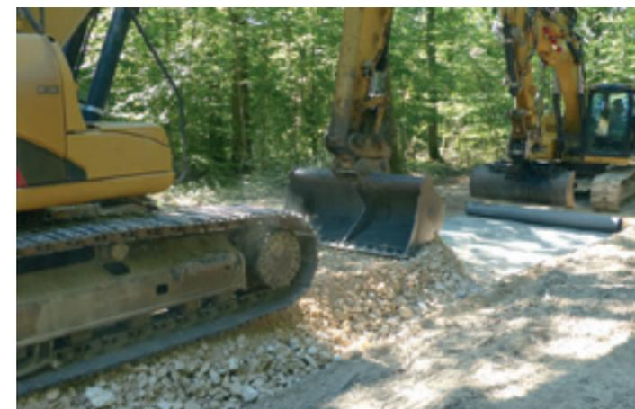
Empierrement sur une épaisseur de 40 cm après la pose d'un géotextile
