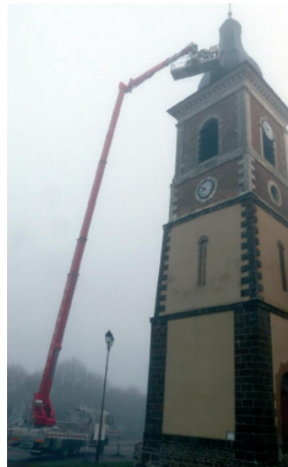
*La nacelle pouvant atteindre une hauteur de 45 mètres pour réparer la toiture du clocher ...dans un épais brouillard*
