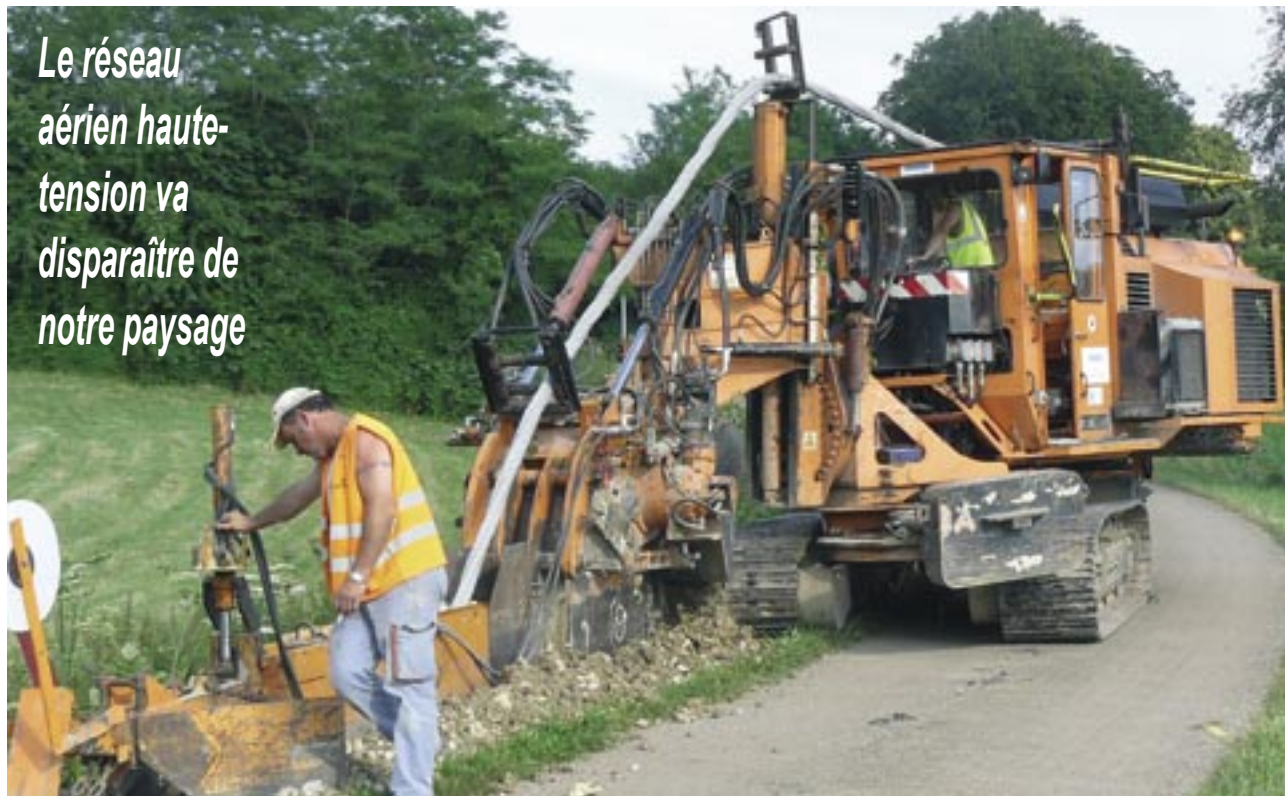
La trancheuse : une machine impressionnante... Elle creuse la tranchée, pose le câble, pose le grillage de protection et rebouche la tranchée !
