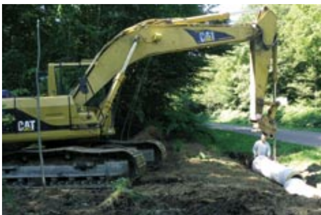
Pose des buses à l'entrée de la route forestière
