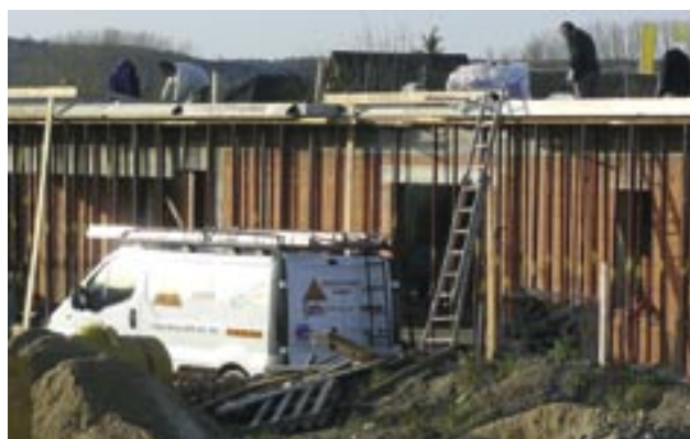
La crèche en construction à Aillant-sur-Tholon
