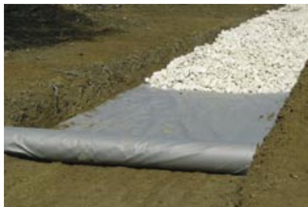
Le film géotextile sous les cailloux
