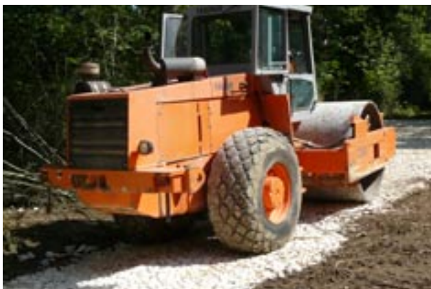
Remise en état du chemin des Fourneaux
