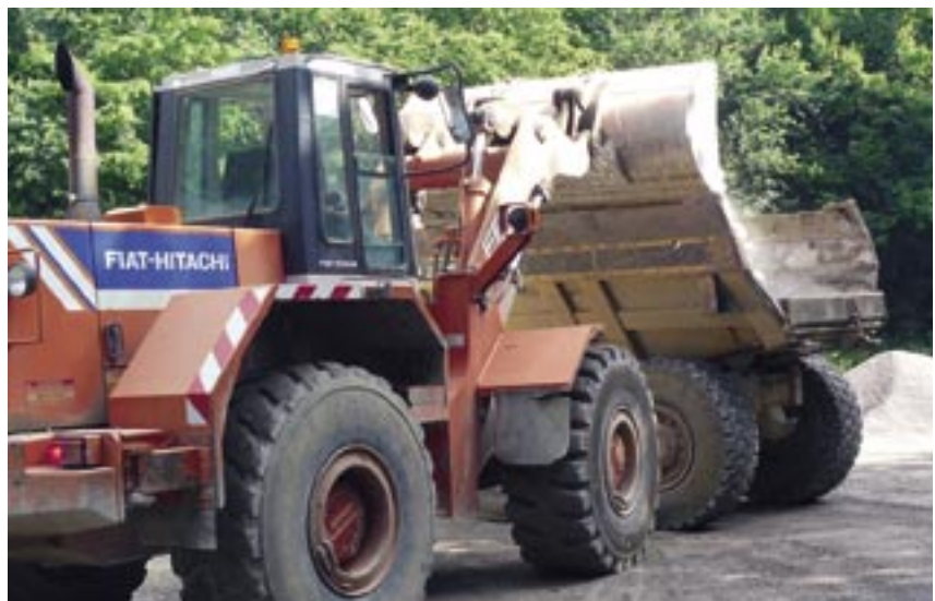
Le chargement dans le dumper
