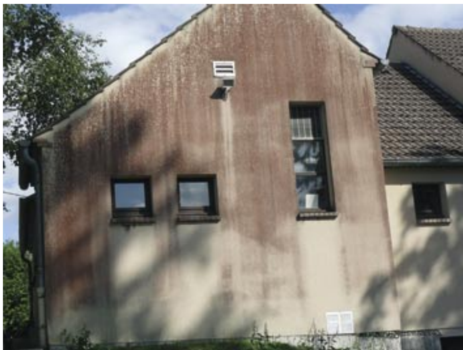
Le pignon nord-ouest et son enduit rougi par les intempéries va être nettoyé
