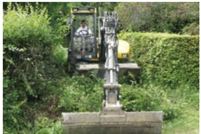
Ce chantier a permis d'améliorer gratuitement l'état de certains chemins. Ci-dessus : la Vaux-Bornat
