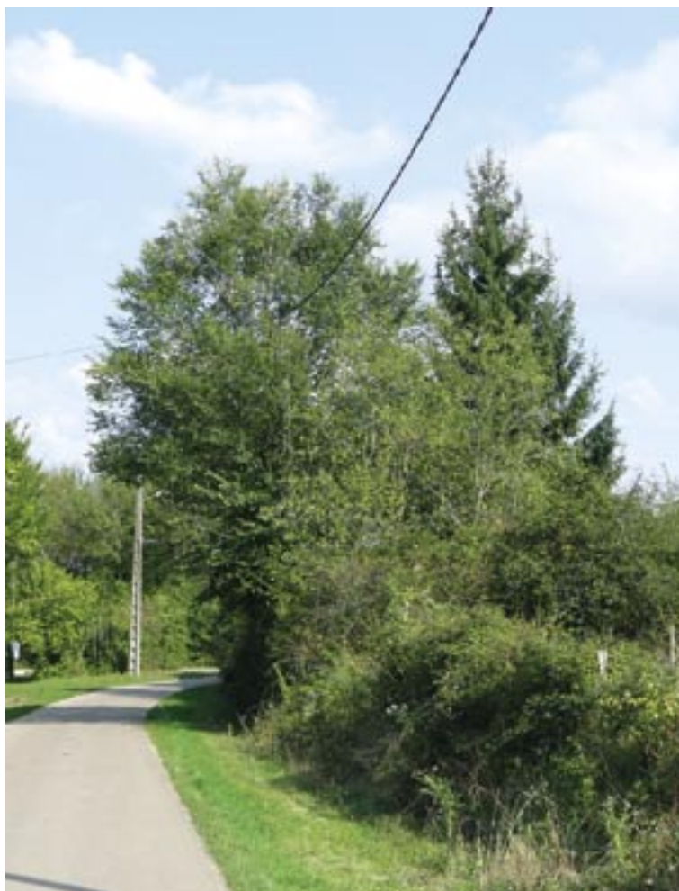
Réseau électrique prisonnier des branchages en surplomb de la voie
