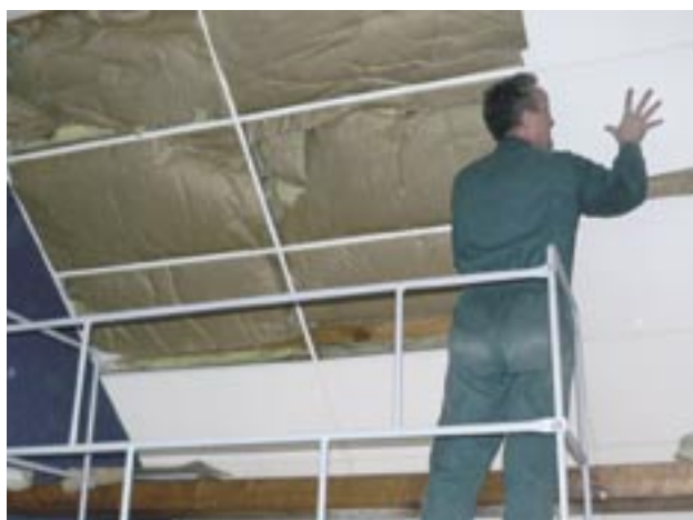
La pose des nouvelles plaques au plafond
