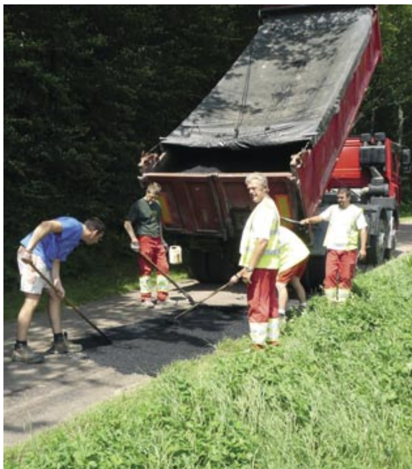
Reprofilage à l'enrobé à chaud, route de la Croix-verte
