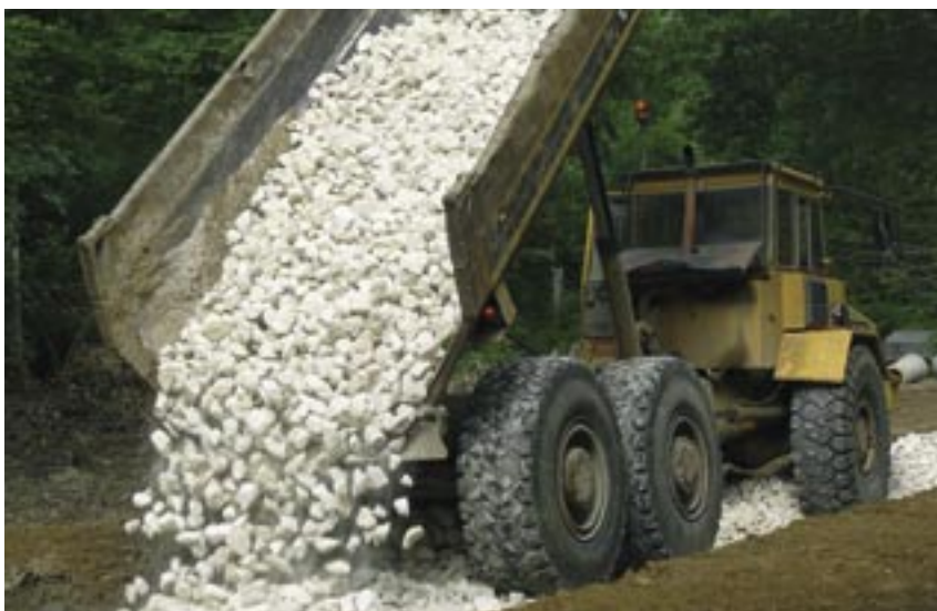
Déchargement des cailloux dans le décaissement
