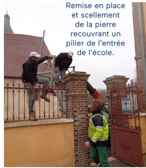
Remise en place et scellement de la pierre recouvrant un pilier de l'entrée de l'école.
