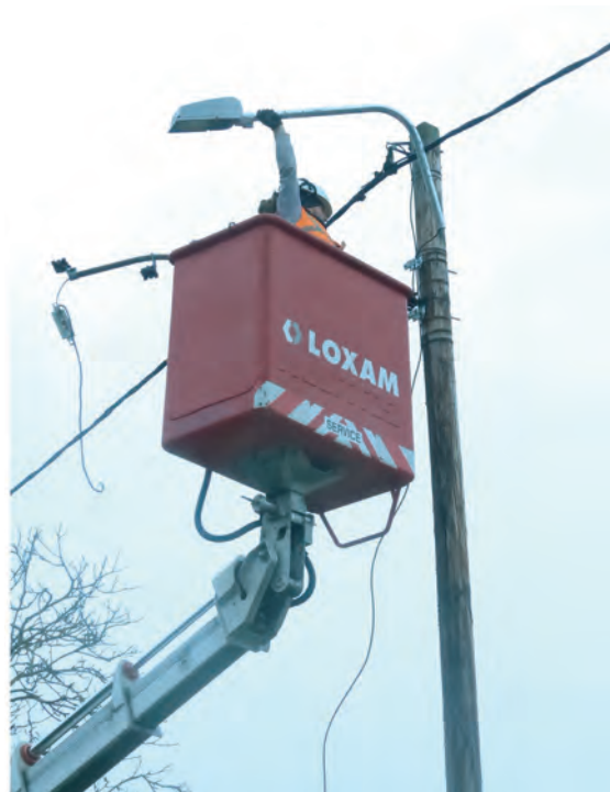
Démontage des lampadaires avec lampes
