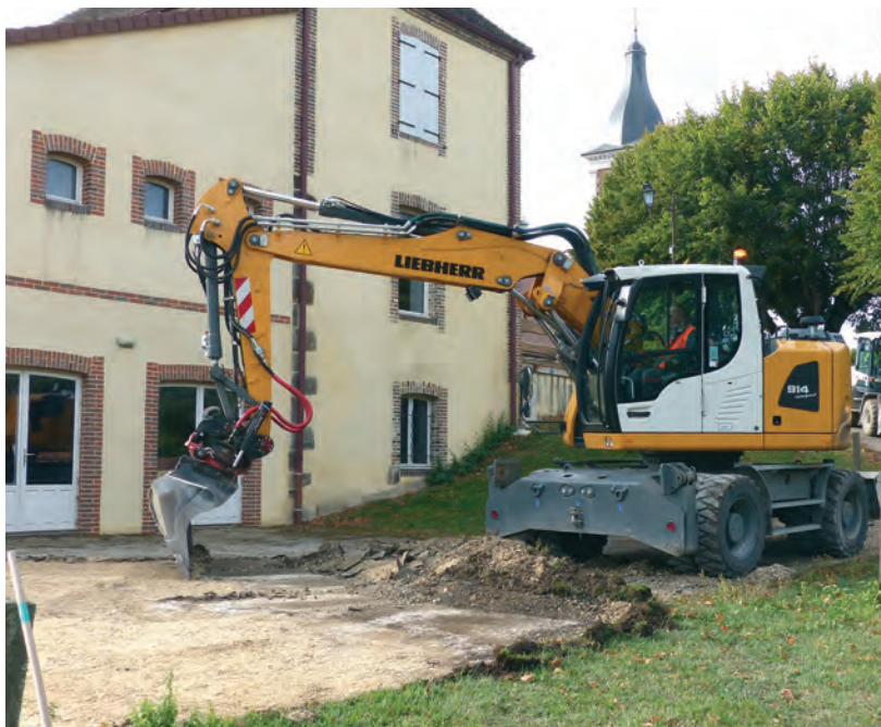
La voie d'accès à l'arrière du restaurant a été refaite. La chaussée était très dégradée : revêtement disparu par endroit, nids de poule, présence de mousse et d'herbe. Les matériaux résultant de l'écroutage ont servi à améliorer l'état de quelques chemins ruraux.
