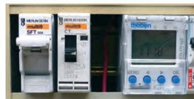
Avec une horloge astronomique, l'installation est simplifiée et la fiabilité augmentée
