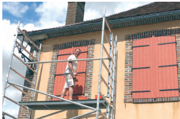
Réfection de la peinture des volets et façade de l'école
