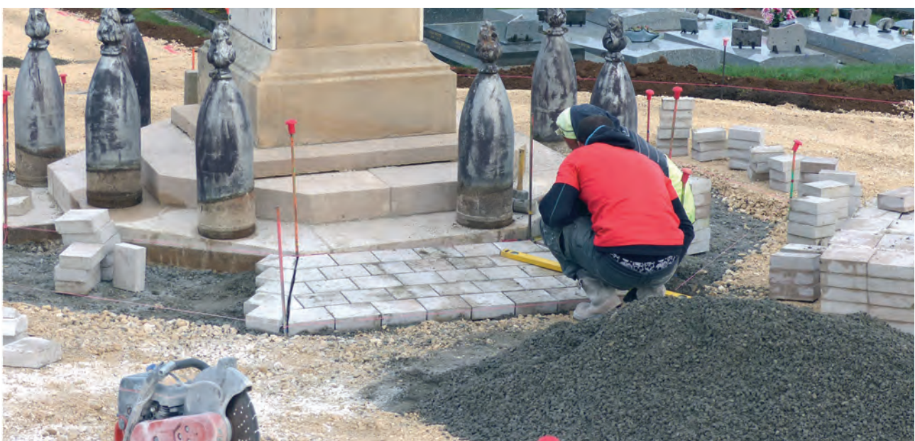
La pose des pavés autour du monument aux morts.
