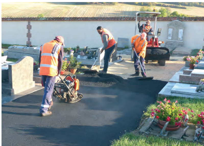
Dans l'impossibilité de manœuvrer avec un finisher dans le cimetière, l'enrobé à chaud est amené avec des petits chargeurs avant d'être étalé au râteau, puis tassé
