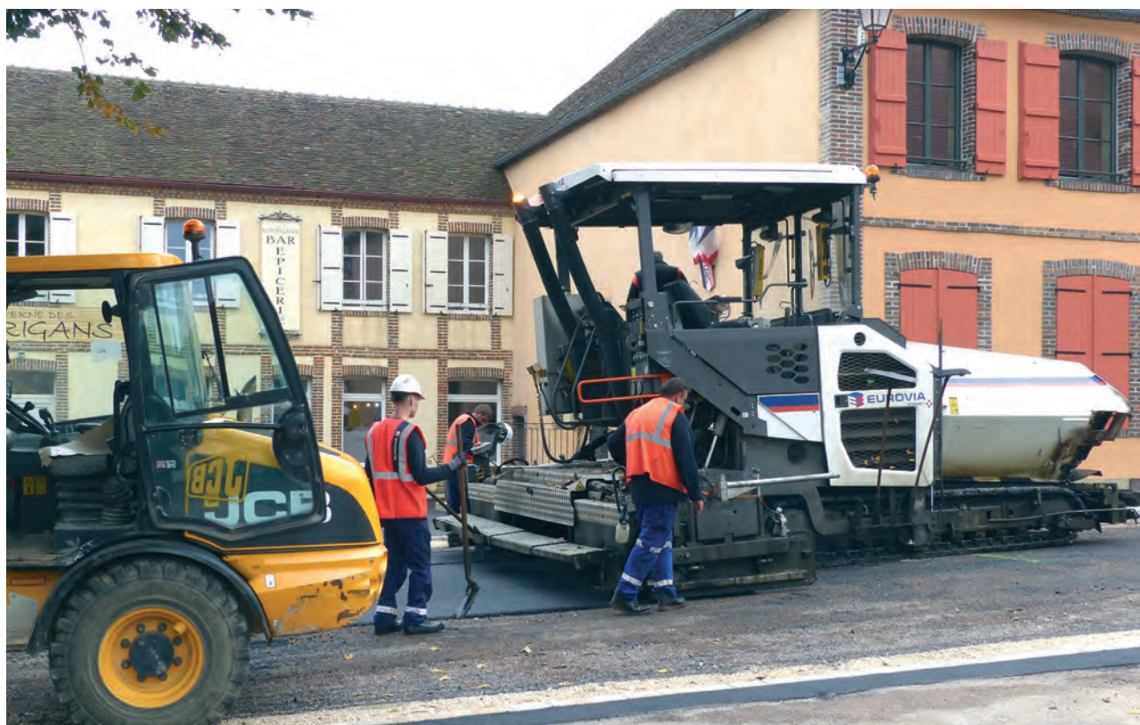
Après la pose de pavés, la reprise du dispositif d'écoulement des eaux de pluie et décapage du vieux revêtement, l'enrobé à chaud est étalé au finisseur
