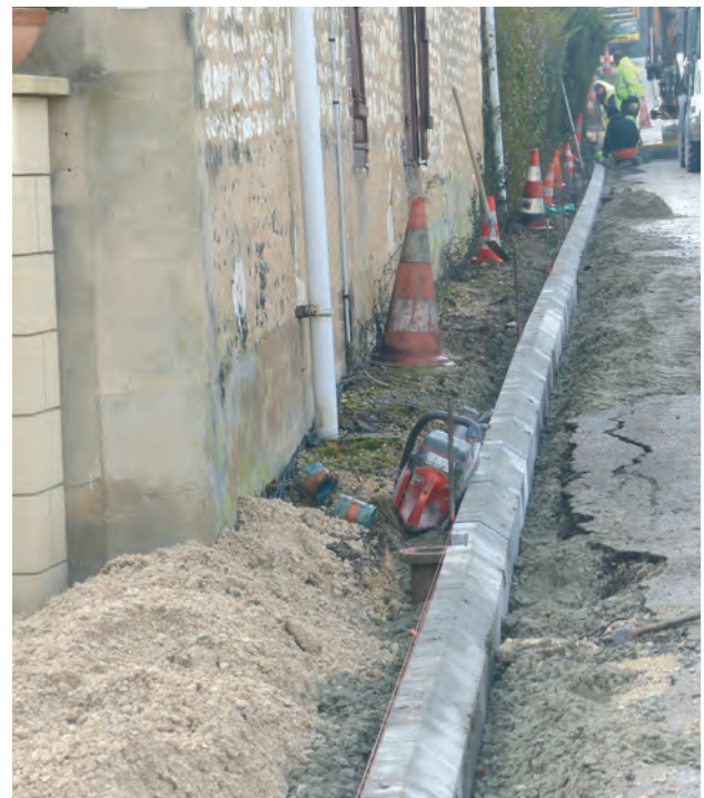
Pose de bordures franchissables pour canaliser l'écoulement des eaux de pluie
