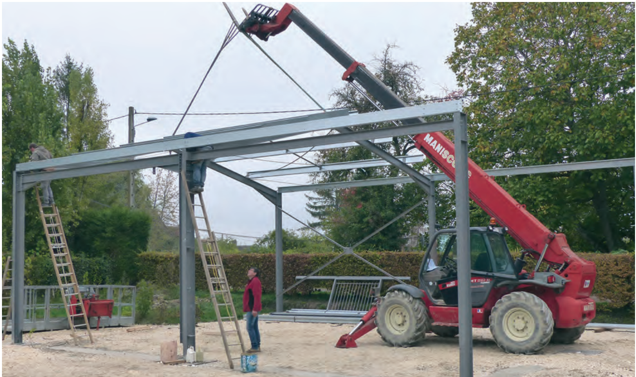
L'assemblage de la structure métallique
