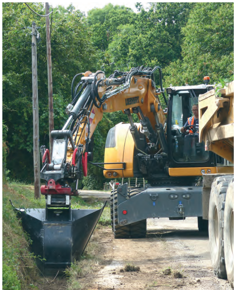
Curage de fossé aux Davids
