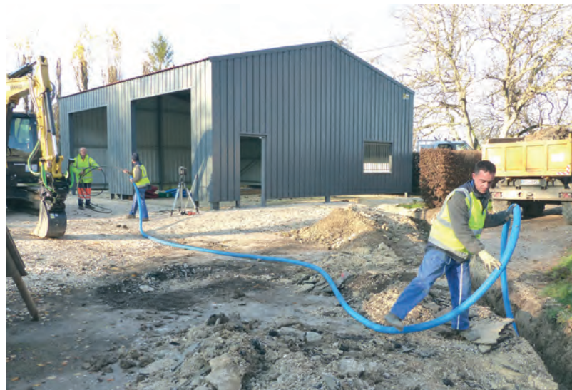
Le raccordement du bâtiment aux différents réseaux
