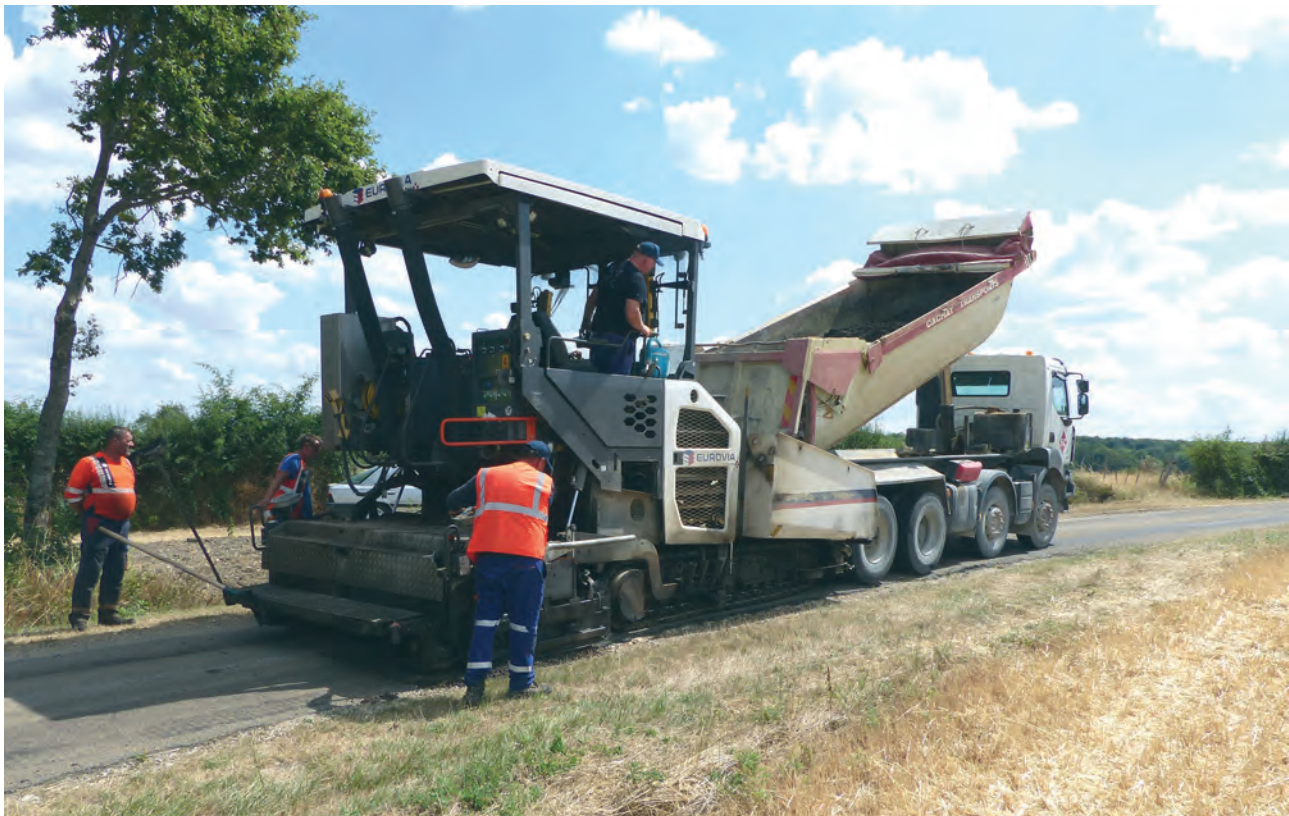
Reprofilage mécanique de la chaussée au finisher avec de la grave émulsion sur les Bois-Jarry, route du Crot à la Fumée. Travaux réalisés par EUROVIA
