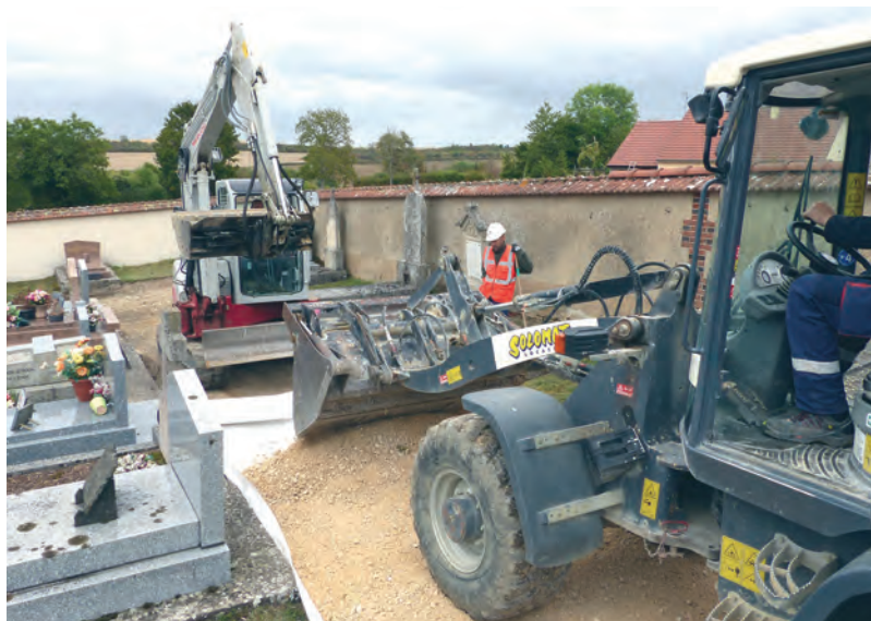
Après décaissement des allées et la pose d'un géotextile, des granulats sont apportés avec des chargeurs et étalés à la pelle mécanique
