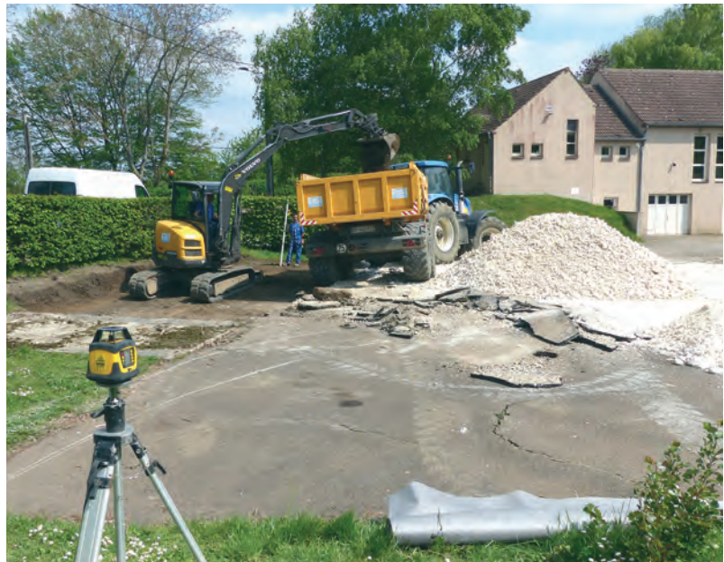
Les travaux de terrassement par l'entreprise MICHALIK
