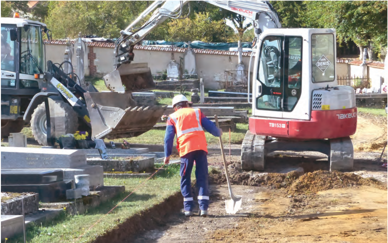
Après écroûtage, les allées sont décaissées sur une vingtaine de centimètres. Les camions ne pouvant entrer dans le cimetière, la terre est évacuée par un chargeur.
