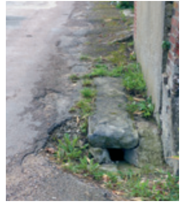
Un avaloir d'eau pluviale au N°3 ...
