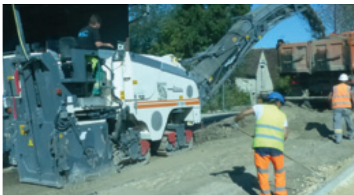
Rabotage de chaussée
