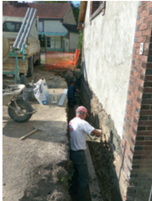
Après terrassement, enduit du bas de mur avant la pose d'un revêtement de protection
