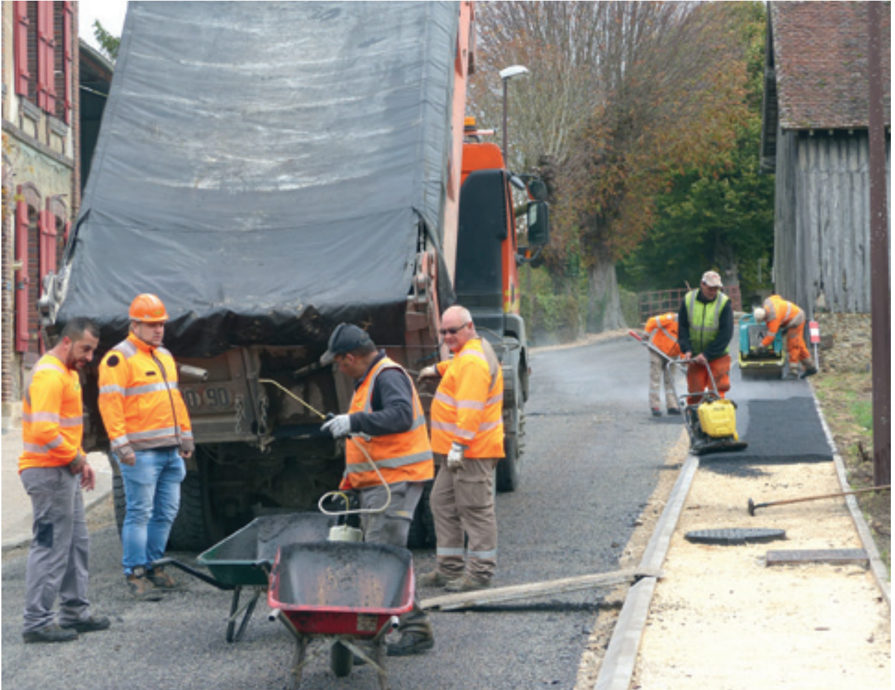
Les travaux rue de l'Eglise - Finition des nouveaux trottoirs
