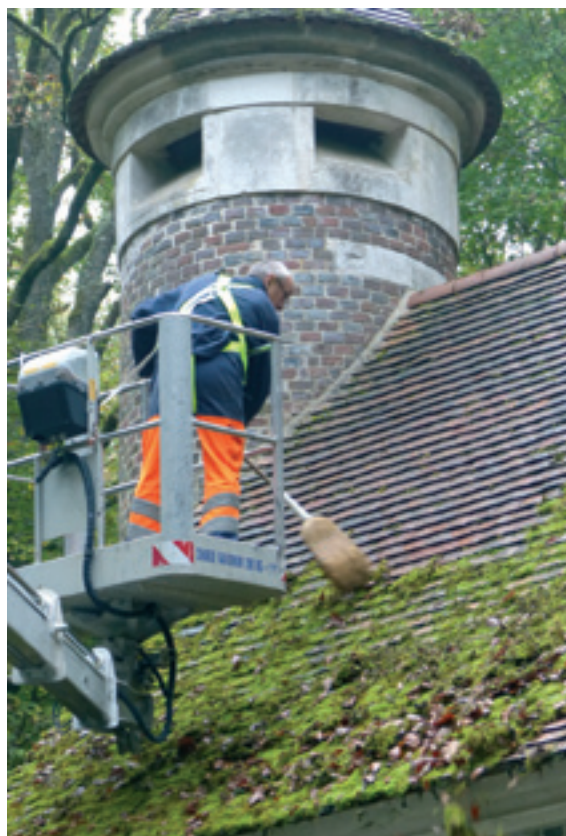
Traitement des tuiles après le brossage de la mousse
