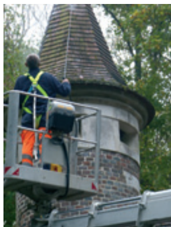
Traitement des tuiles après le brossage de la mousse
