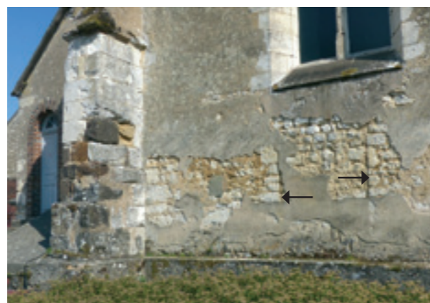
L'église avant travaux 2016 Sous la fenêtre, on distingue les pierres d'encadrement (flèches noires) de la porte d'entrée de l'ancienne sacristie. Elle a été murée contrairement au devis de 1767, qui prévoyait un accès au cimetière.
