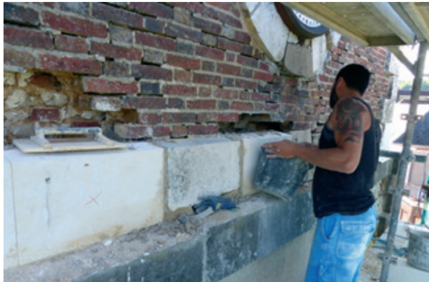
Remplacement des pierres gelées A gauche, on remarque le trou laissé par les briques qui se sont écroulées en l'absence de joints et de liaison avec le mur arrière
