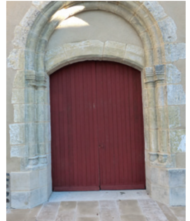
Les pierres érodées du portail ont été changées et vieillies artificiellement
