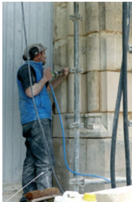
Remplacement des pierres d'encadrement du portail rongées par le temps
