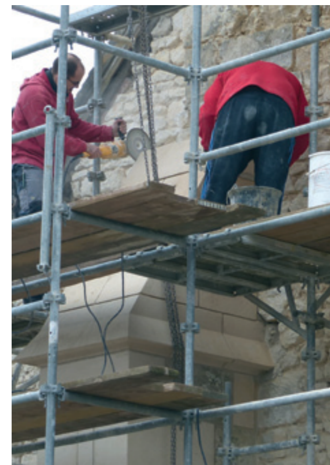
Réfection du contrefort situé à côté de l'entrée de la sacristie
