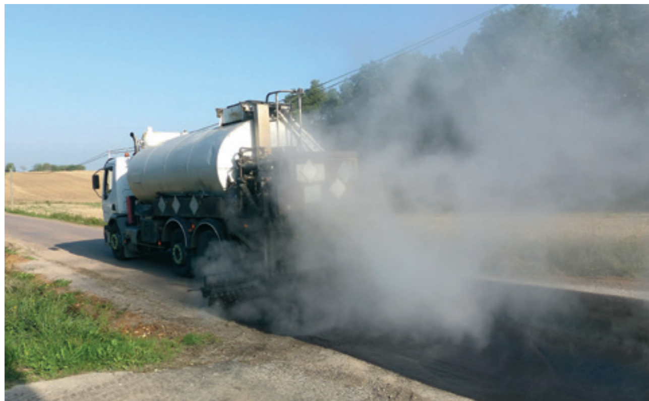
Recouvrement de la voie par du goudron à haute température avant l'épandage du gravillon
