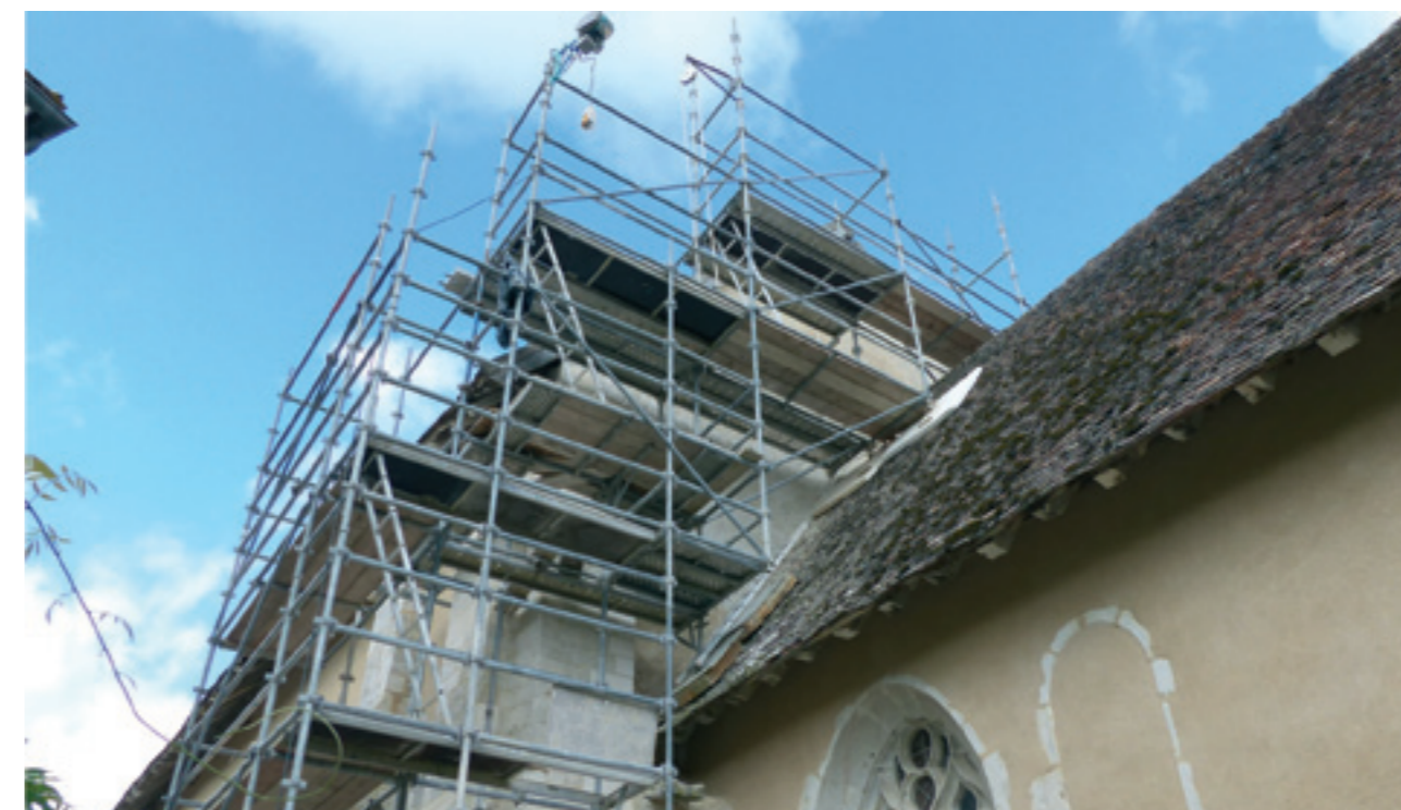
Un échafaudage difficile pour atteindre le pignon est
