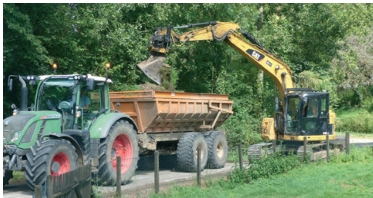
Dérasement d'accotement aux Naudins
