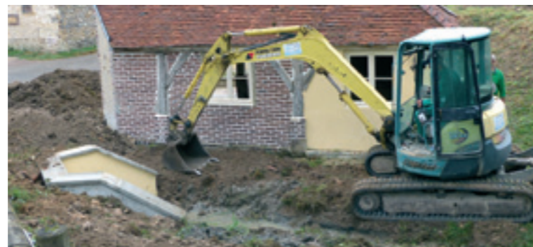
Terrassement des abords au cours de l'été
