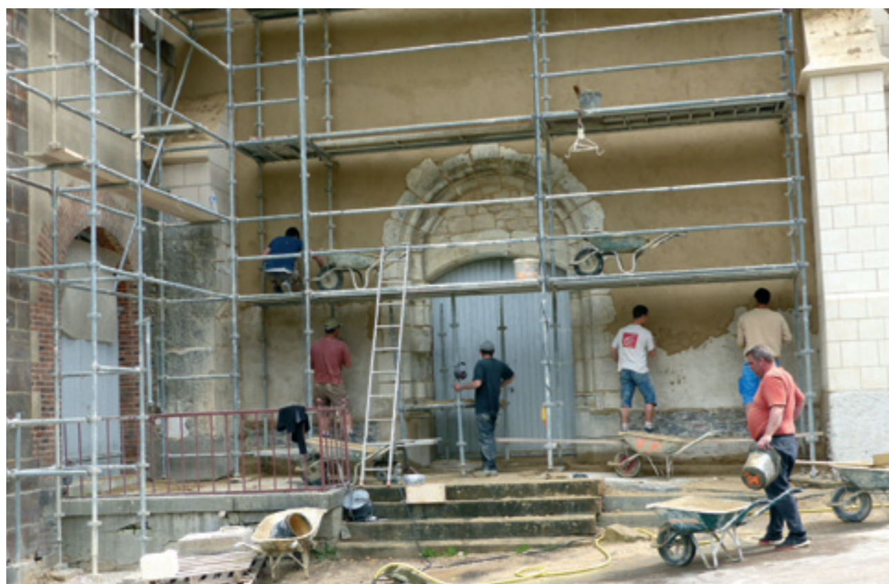
L'enduit final du pignon d'entrée après un dégrossi. L'enduit est constitué d'un mortier de chaux teinté avec du sable jaune de Saint-Amand-en-Puisaye et appliqué manuellement. On remarque à droite le contrefort entièrement refait en pierre ; à gauche, seule la partie supérieure a été refaite
