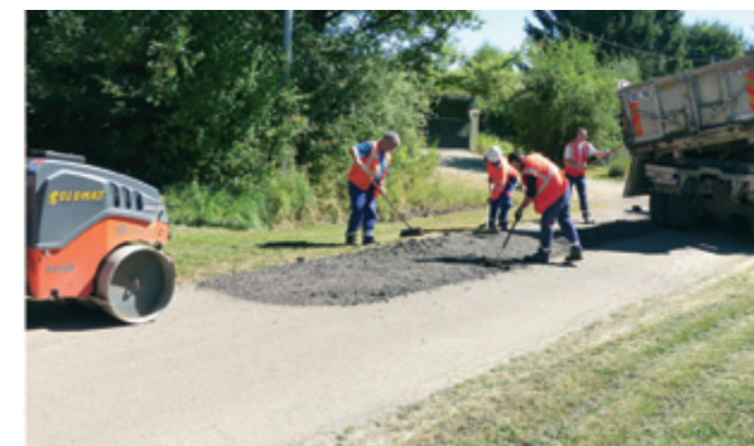
Reprofilage manuel sur la VC4 à la Fumée, près de la mare de Vaux
