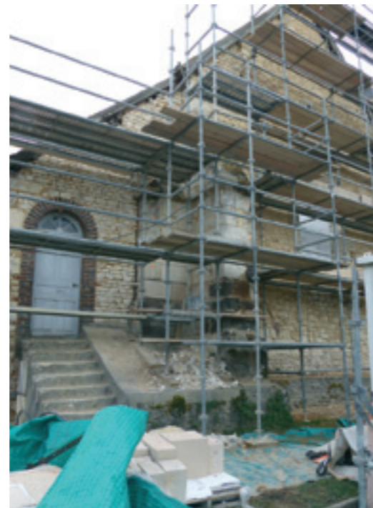
Démontage partiel de la couverture pour changer la sablière pourrie
