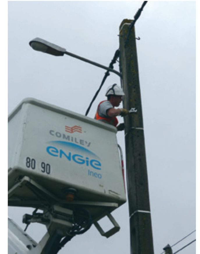
Démontage d'un vieux lampadaire avec ampoule
