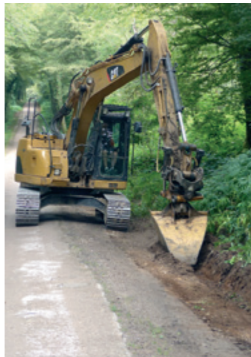
Curage de fossé route de Parly
