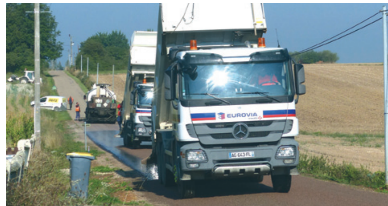
Deux camions gravillonneurs suivent de près, en marche AR, celui qui vient d'épandre le goudron avant que ce dernier ne refroidisse
