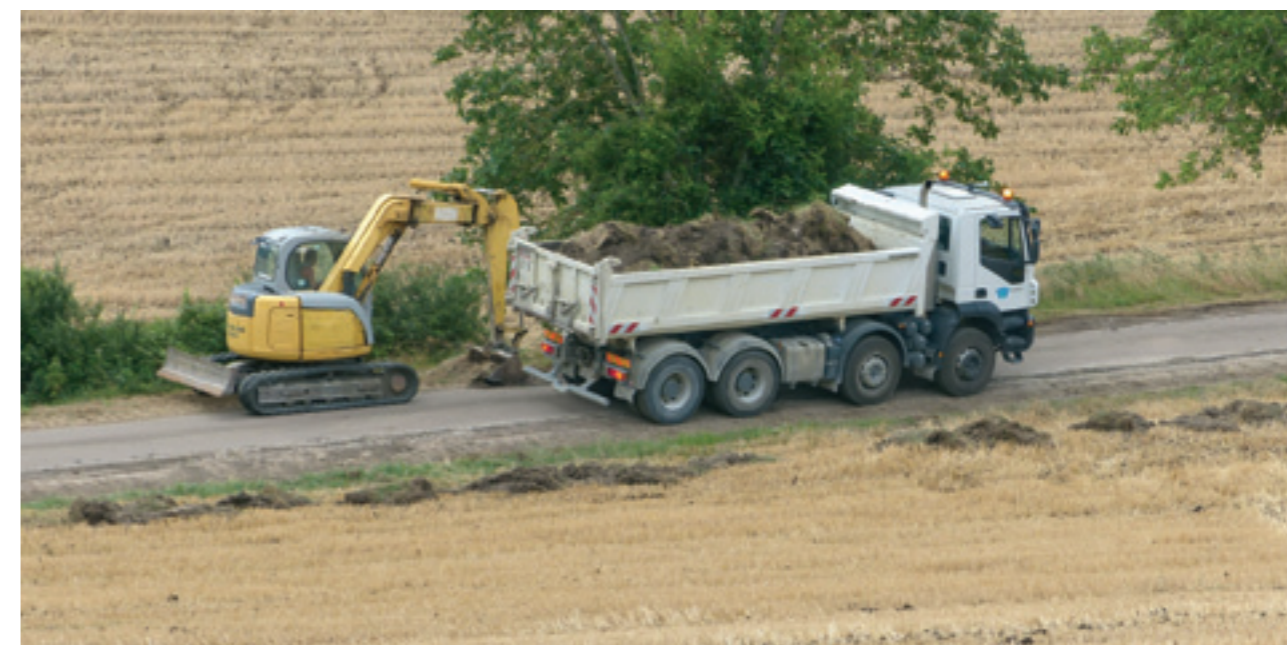
Dérèglement d'accotement rue de la Vaux Au fil du temps, la hauteur des accotements s'élève à cause de l'herbe broyée qui reste sur place, l'eau de pluie ne peut plus s'écouler correctement dans les fossés et stagne ou s'écoule sur la route, d'où la nécessité d'un dérasement régulier des bas-côtés
