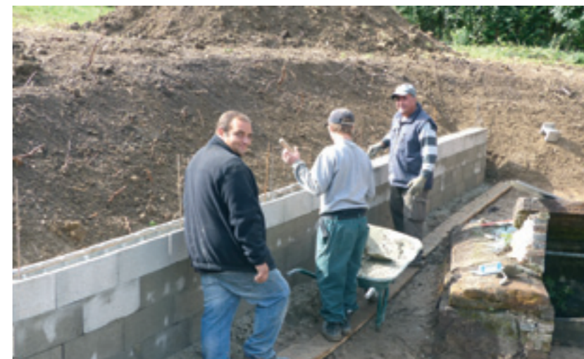
Les ouvriers de l'association EMERAUDE au travail dans cet atelier chantier d'insertion
