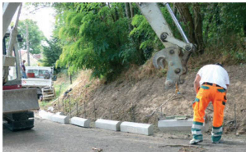
Pose de bordures dans un virage pour canaliser les eaux de pluie
