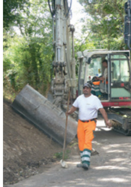
Travaux routiers au Chêne
