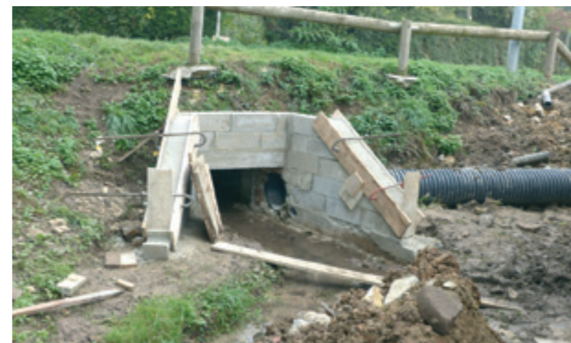
Réfection de la tête d'aqueduc qui s'était écroulée. L'aqueduc permet le passage du ru de Minard et le trop plein du lavoir sous la route
