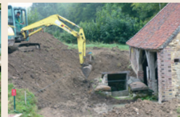
Terrassement au lavoir du Crot
