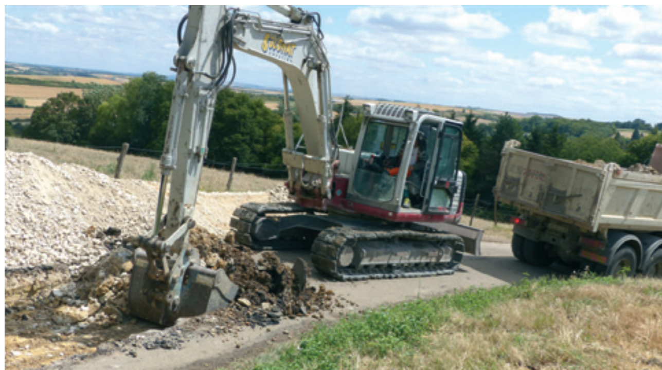
Traitement de choc pour éliminer les importantes déformations sur la VC2 dans le haut de la Vaux des Huchons. Purge sur 50 cm de profondeur de la couche d'argile et remplacement par des cailloux.
