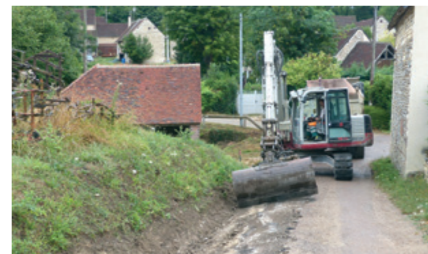
Réfection de la VC20 au Crot
