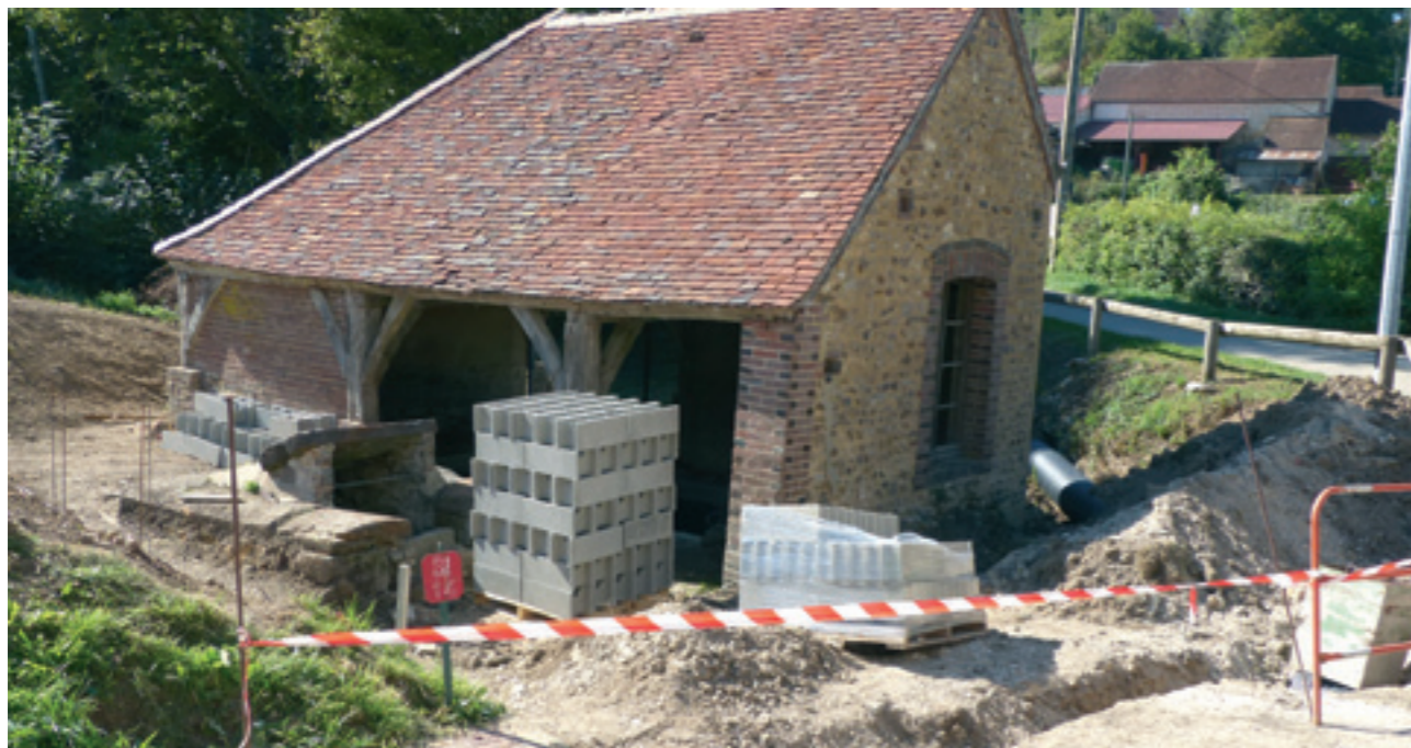
Le lavoir après les travaux de terrassement préliminaires ; la fontaine a été dégagée, l'assainissement et l'évacuation des eaux refaits. Les travaux de maçonnerie débutèrent par la construction d'un mur en béton pour soutenir la terre du champ voisin.
