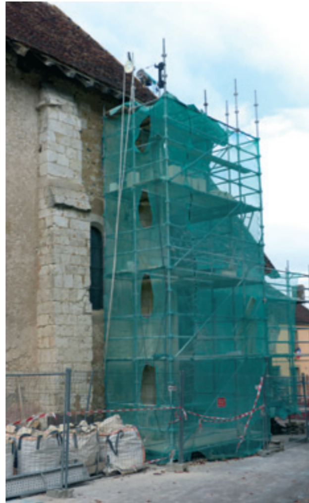
Le début des travaux : Ils ont commencé par la réfection d'un contrefort sud très endommagé
