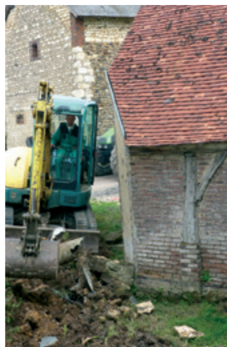
Travaux au lavoir du Crot
