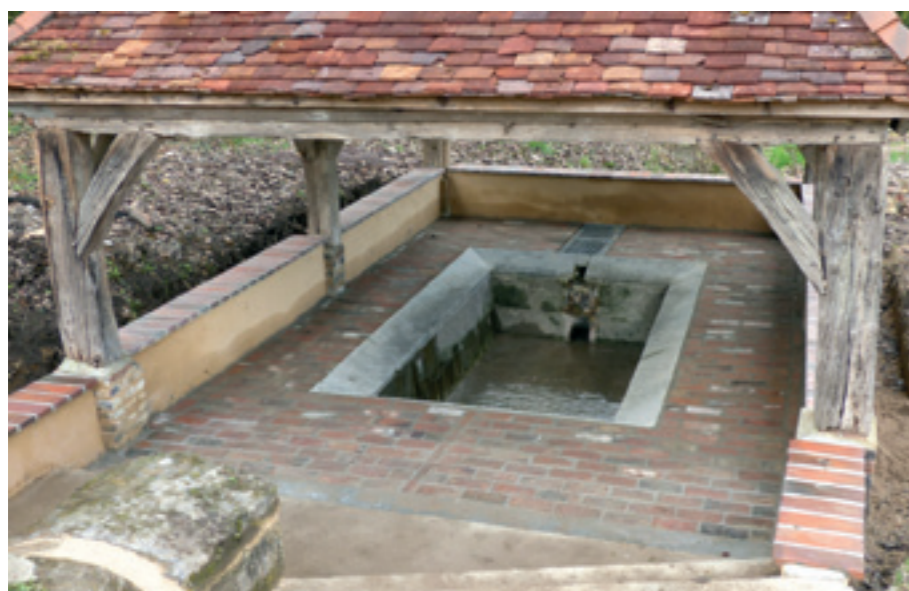
Le lavoir en cours de restauration
