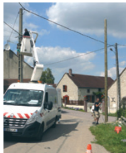
Réparation des dégâts par une société privée
