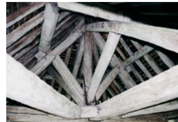
L'imposante charpente du lavoir
