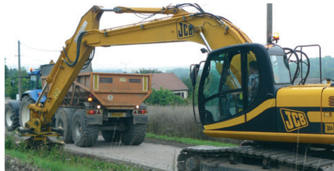
Curage de fossés avec du matériel adéquat, route de Saint-Aubin. Matériel souvent en difficulté en raison des branchages de particuliers qui négligent leurs obligations en matière d'élagage
