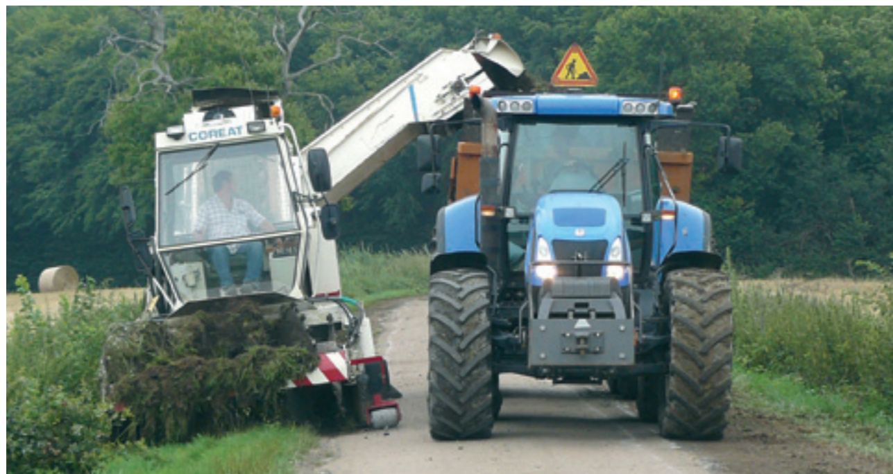
Un engin particulièrement efficace et rapide pour un dérasement parfait des accotements, route d'Arthé
