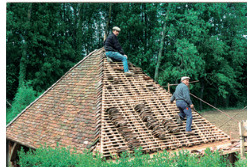
Réfection de la couverture du lavoir en 1994 par l'entreprise de maçonnerie Genreau de Merry (Photo M.P.)
