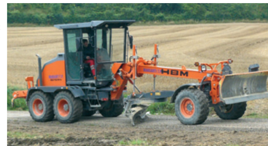
G.P. Reprofilage à la grave émulsion, à l'aide d'une niveleuse dans le bas du Crot sur la VC21
