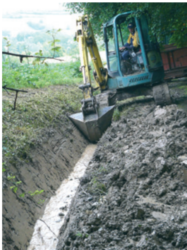
Réfection de fossé dans le chemin de la Mouotte
