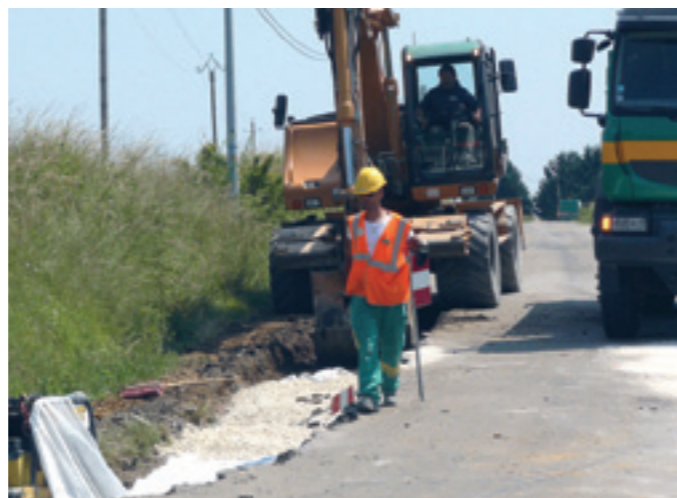
Reprise en profondeur route de Parly. Les parties instables de la chaussée sont renforcées avec une couche de 40 cm de calcaire
