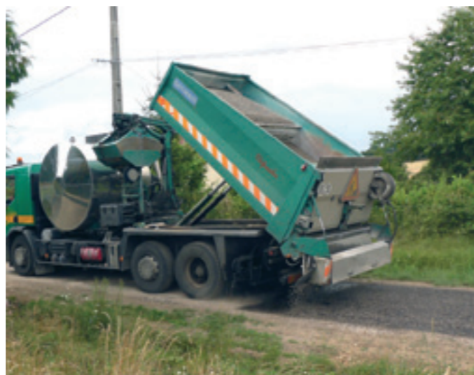
Application d'une couche de bitume d'accrochage avant le reprofilage au finisher
