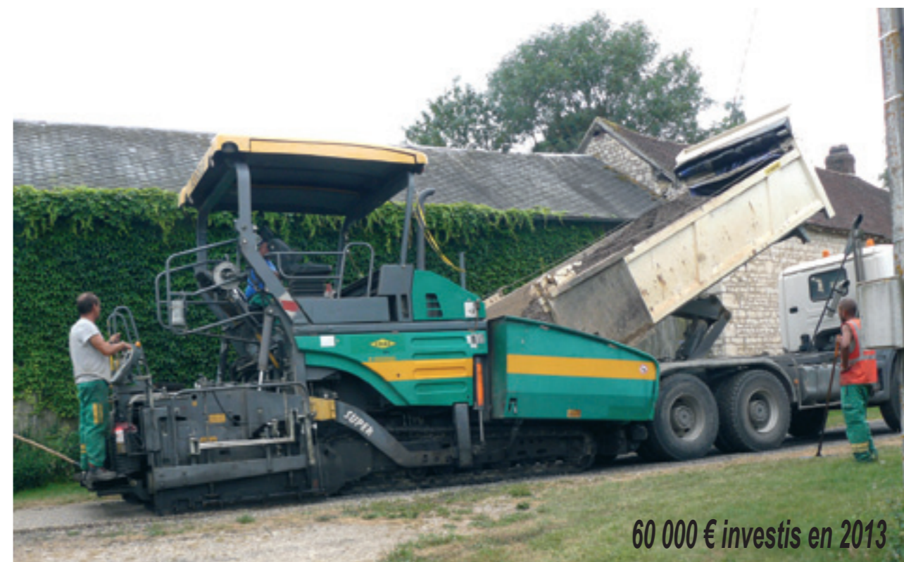
Reprofilage à la grave émulsion de la chaussée au finisher, route des Noues
