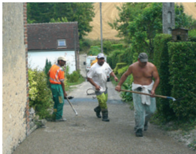
Gravillonnage manuel dans la rue des sabotiers
