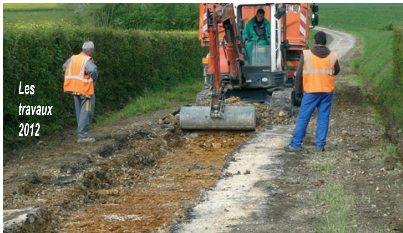
Importantes reprises en profondeur route de Rhodes sur une centaine de mètres
