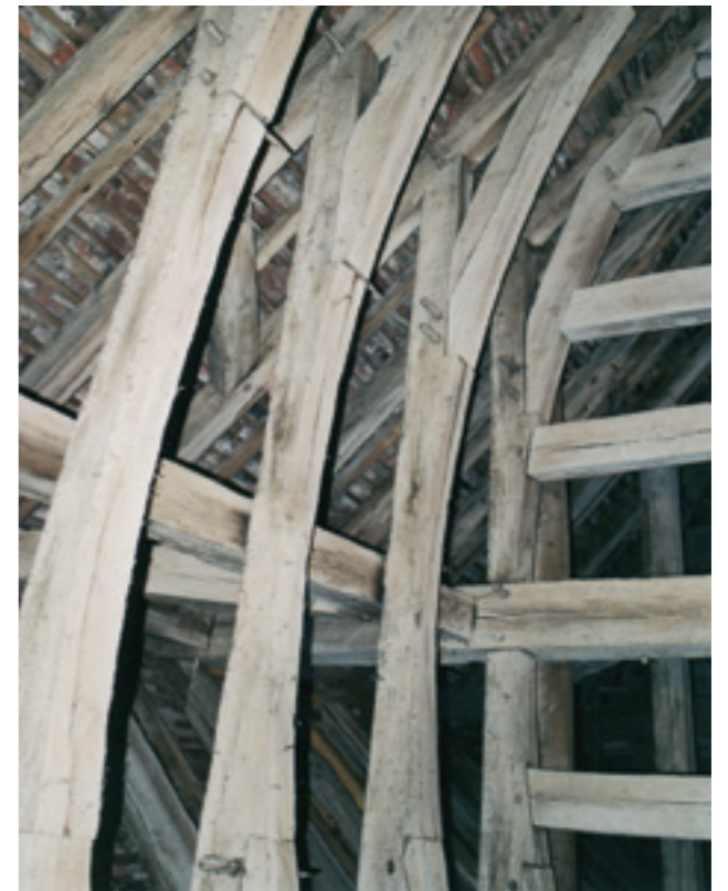
Une partie de la charpente de l'église
