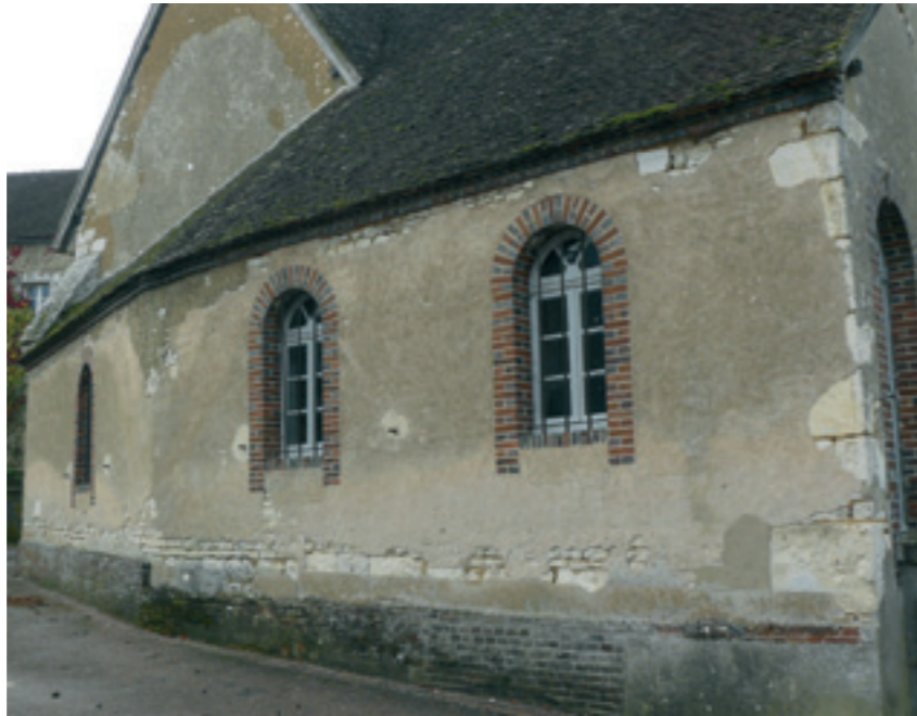
L'arrière de l'église n'offre pas une perspective très agréable aux utilisateurs du bâtiment école-mairie et aux visiteurs...
