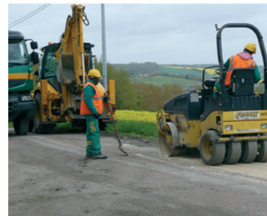
Reprofilage de la chaussée à la grave émulsion sur la route du Crot à la croix de Saint-Marc
