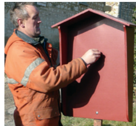
Nos panneaux d'affichage en bois, installés depuis de nombreuses années, commençaient à tomber en ruine sous l'action des intempéries. De nouveaux ont été fabriqués et posés par l'employé communal. Un fond amovible pourra être changé quand le nombre d'agrafes deviendra trop important.
