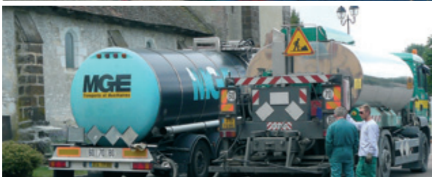
La citerne de goudron fait le plein au semi en attente sur la place
