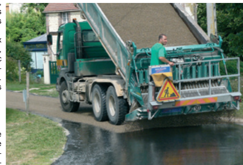
Le gravillonnage... en marche arrière. Du travail de pro du volant !
