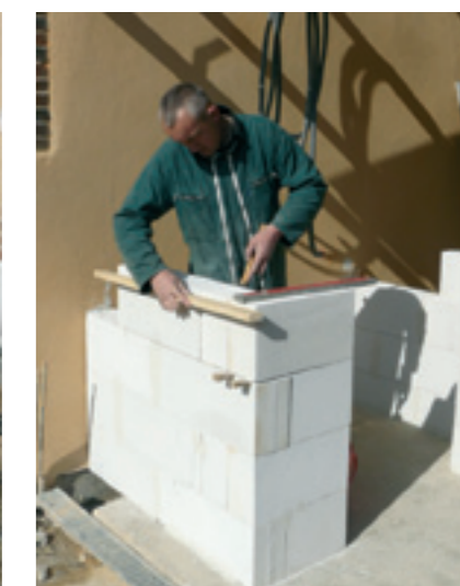
La chaufferie, initialement prévue à l'intérieur, passe à l'extérieur à notre demande. Montée par nos soins devant le coût exorbitant demandé par les entreprises
