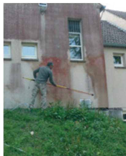
Nettoyage de la façade rougie par les intempéries
