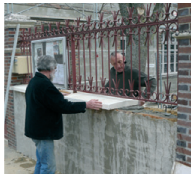
Les briques sur le mur de la cour de l'école n'étaient pas récupérables. Nous les avons remplacées par des dessus préfabriqués blancs
