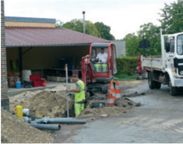
Les travaux de reconstruction du réseau d'eaux pluviales : nouvelles tranchées, regards, grilles, il a fallu tout refaire
