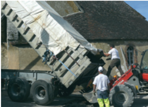
Remplissage du godet en enrobé pour alimenter le mini-finisher en action dans la cour. En arrière plan, le triste état du mur de l'église
