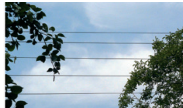
Remplacement de poteaux électriques vieillissants dans la ruelle entre le Chêne et le Crot. Avec ces poteaux, la dernière ligne électrique en fils nus de la commune a disparu au profit d'un câble unique. La sécurité en approvisionnement d'énergie est ainsi améliorée dans un secteur où on a laissé croître de grands arbres trop près du réseau
