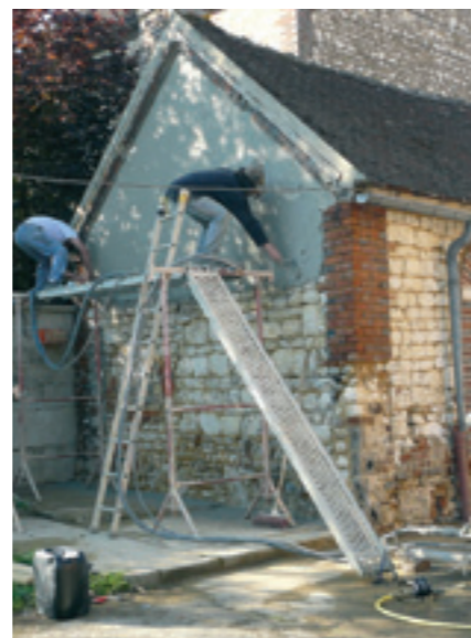
Les murs de la cantine ne pouvaient rester en l'état ! Après démontage de l'appendice en pignon, les parties en pierre ont été reprises
