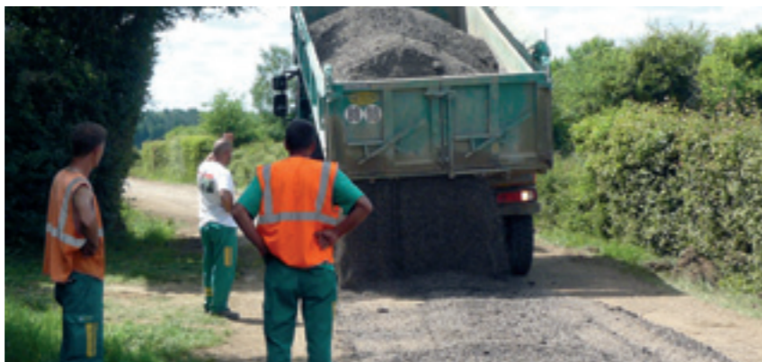
Plus de 60 tonnes de grave émulsion seront nécessaires pour reprofiler 450 m de route à partir du carrefour de l'Ormeau !
