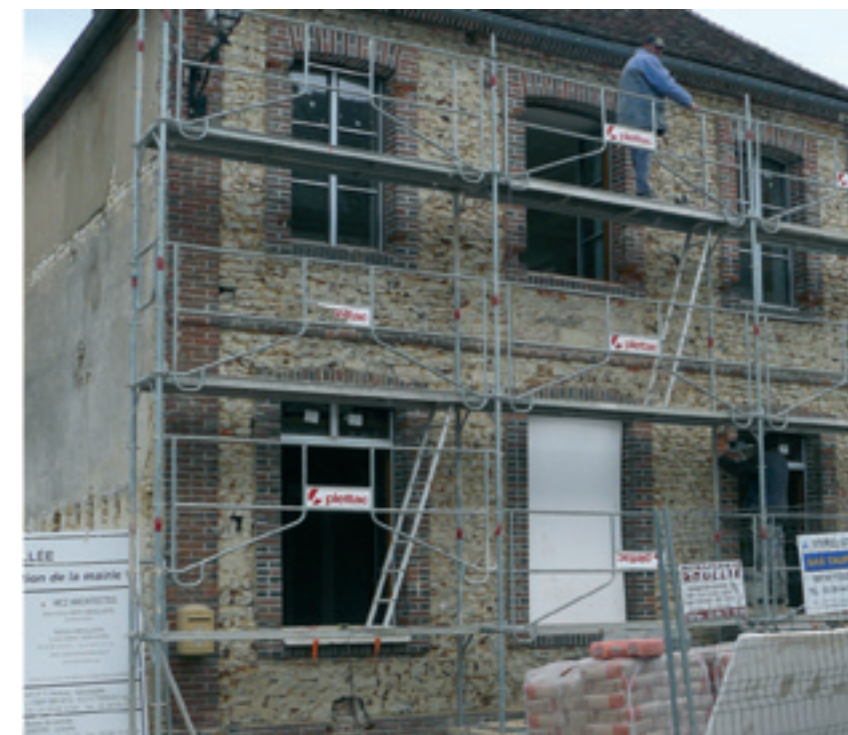
Préparation des murs extérieurs pour l'enduit
