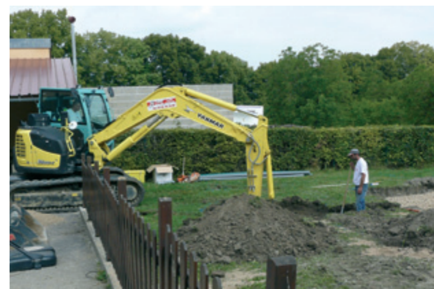
Assainissement : La réalisation du trou destiné à recevoir la fosse septique toutes eaux
