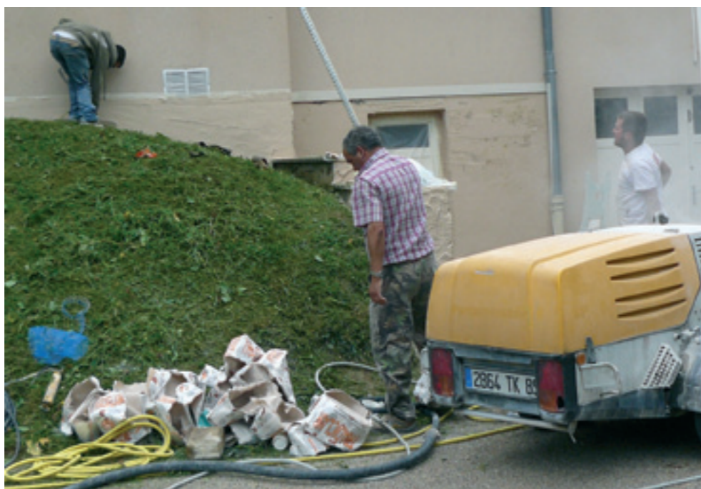
Reprises d'enduit à l'arrière de la salle des fêtes
