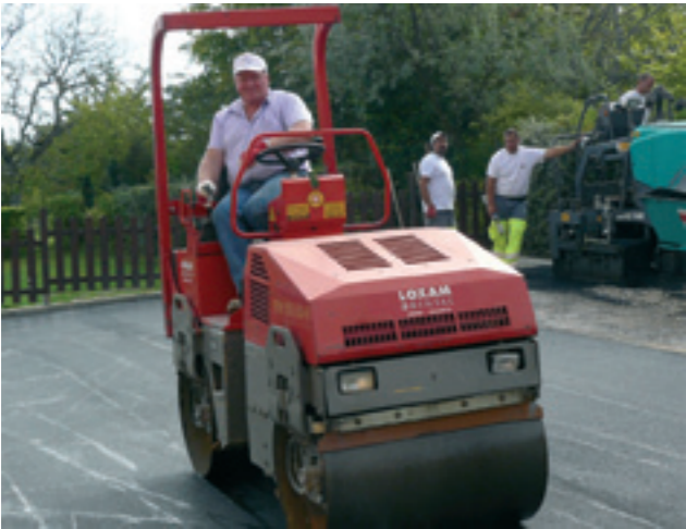
Le patron Jean-Louis Bansard compacte l'enrobé à chaud tout en surveillant le bon déroulement des travaux
