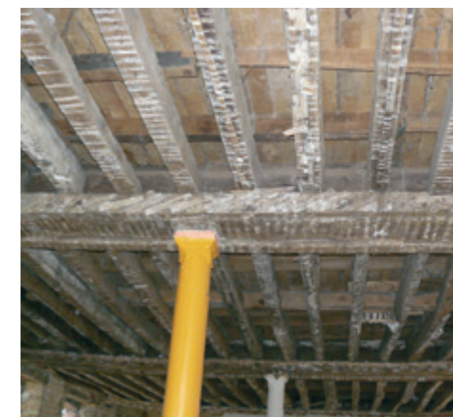
Après enlèvement du faux plafond et des lattes recouverts de plâtre de l'ancien plafond, la structure bois apparaît. Les solives sont de taille respectable mais les poutres ont une section un peu faible compte tenu de la portée, ce qui explique la présence de poteaux.
