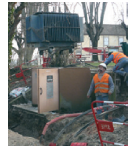
Dépose de l'ancien transformateur électrique au pyralène, allée du cimetière
