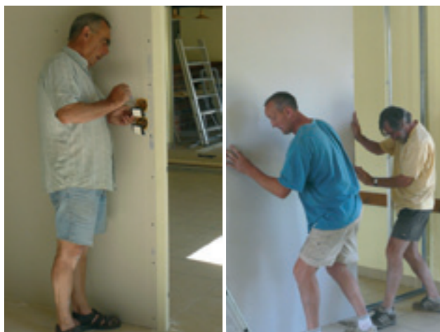
Modification de l'installation électrique
