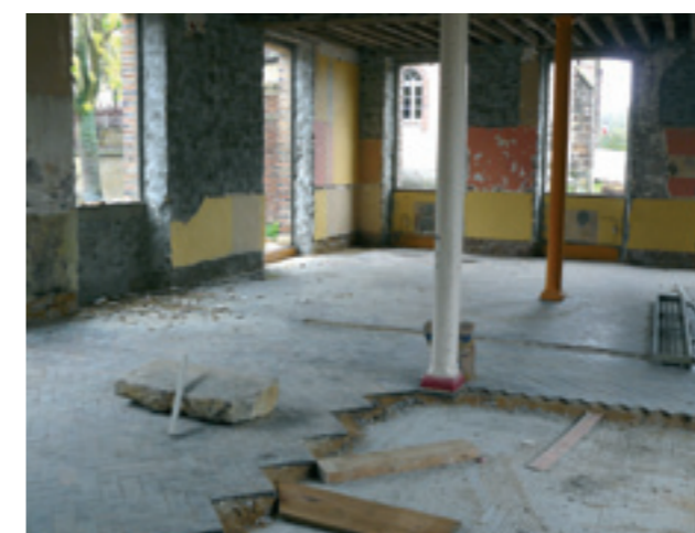
La salle de classe après le début des travaux ... Au sol, le bloc de grès qui servait d'appui à l'escalier
