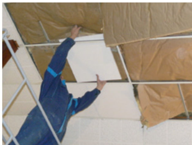
Changement des vieilles dalles de plafond déformées et salies dans la grande salle et remaniement de l'isolation
