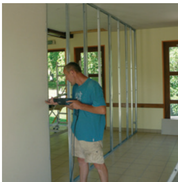
Montage de la cloison de séparation entre les deux salles de classe
