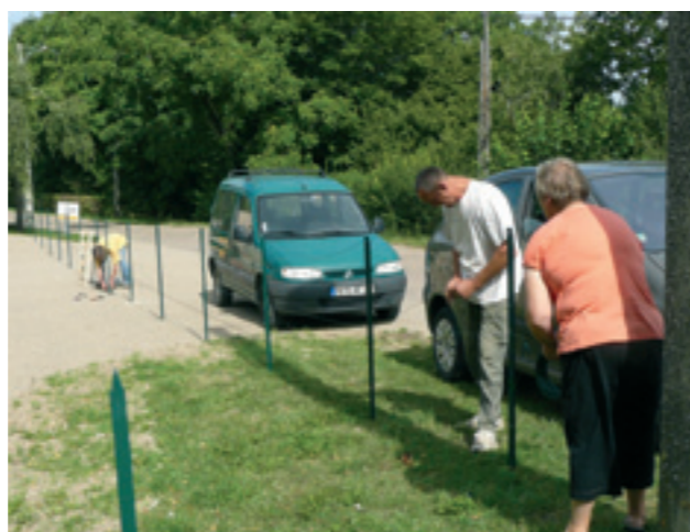
Implantation de la clôture provisoire pour la sécurité des enfants
