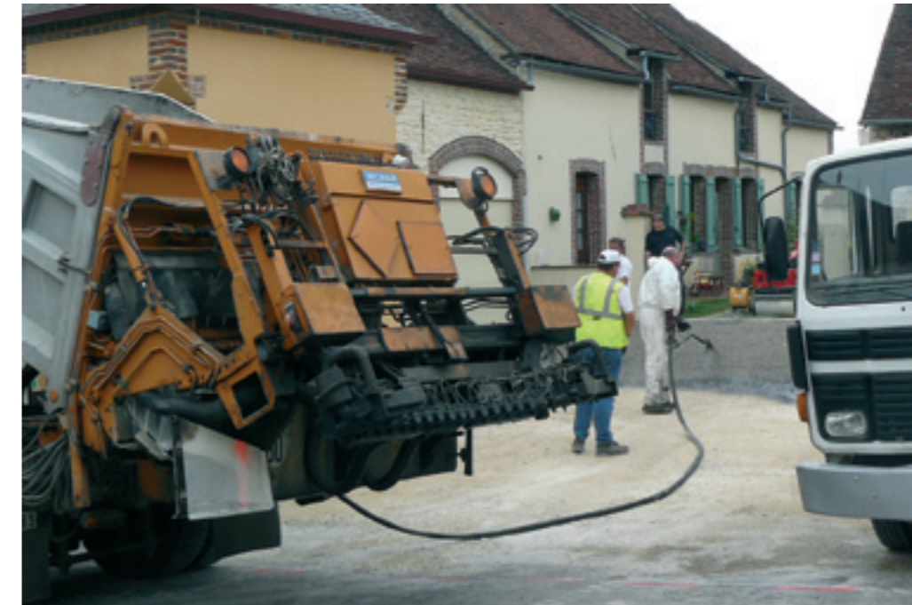
Le gravillonnage de la cour du cabinet médical pour un meilleur accueil du public
