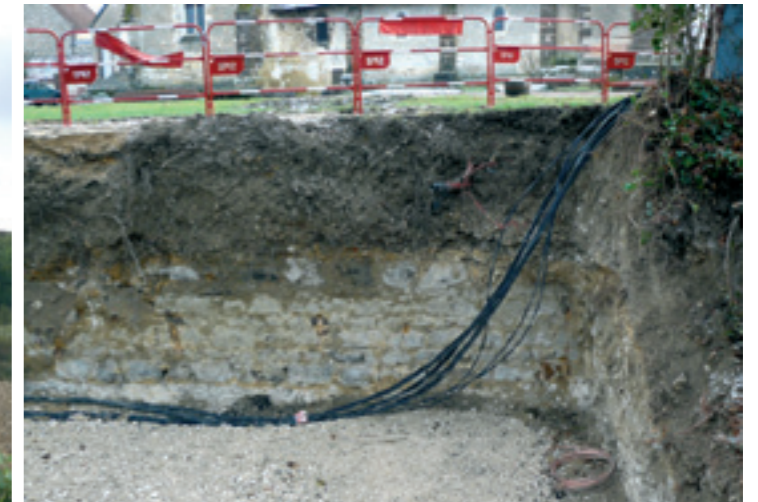
Le terrassement pour le nouveau transformateur met au jour le mur d'enceinte nord ouest de l'ancien cimetière. Mur encore en bon état
