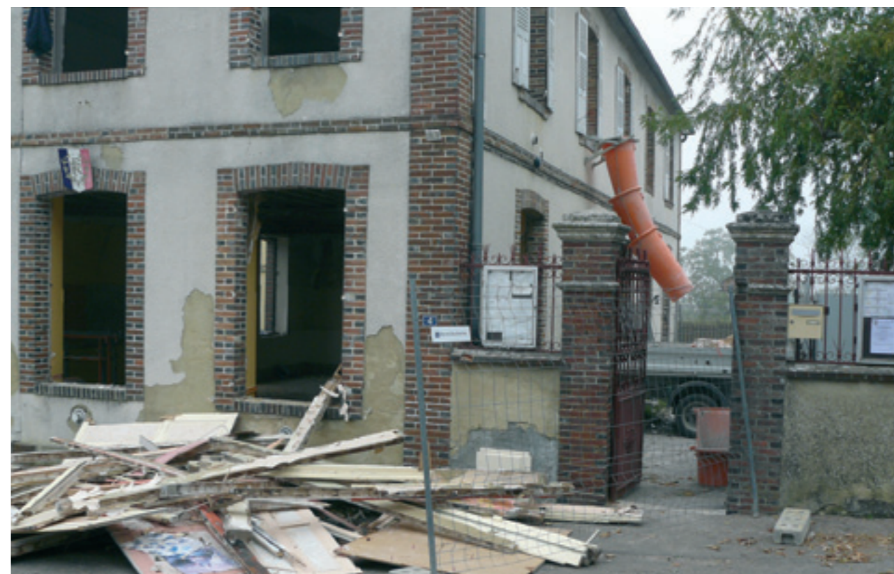
Première étape : le démontage des cloisons, des menuiseries et des plafonds
