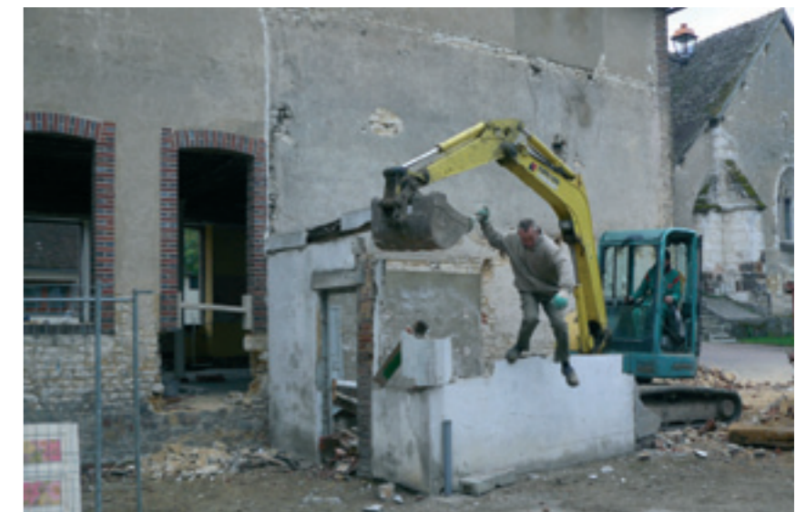
La démolition du local au mois d'octobre. On distingue déjà la future porte d'entrée de la mairie
