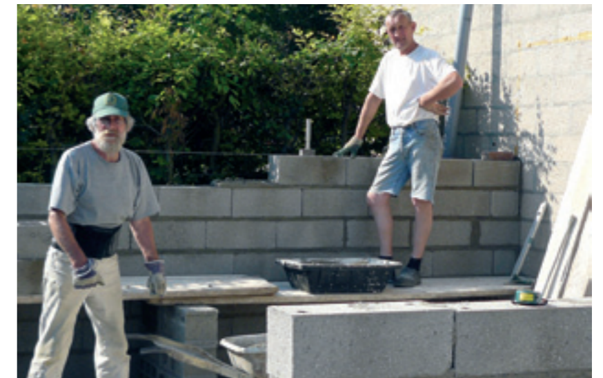
La construction de la remise au mois de juin
